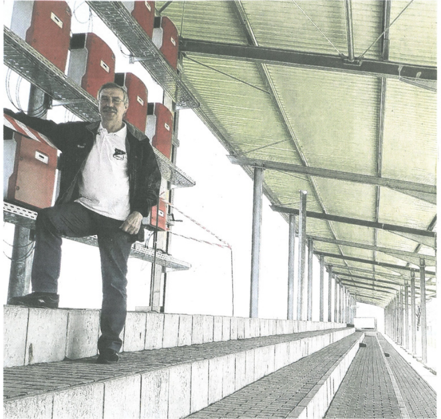
Endlich fertig: Klaus Lemmer wird am Samstag die Fotovoltaikanlage auf dem Tribürendach in Betrieb nehmen.
